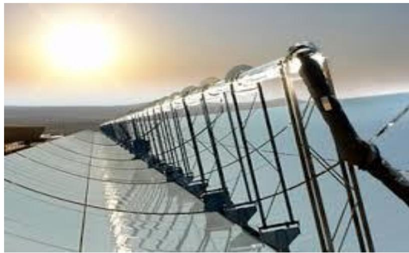
Plantas termosolares con tecnología de canal parabólico, propiedad de SENER, España, 100 MW.
