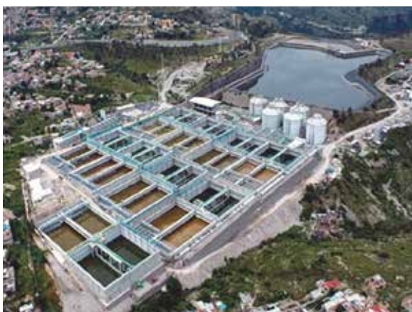
Figura 3.24. PTAR con recuperación de biogás en Agua Prieta, Jalisco
