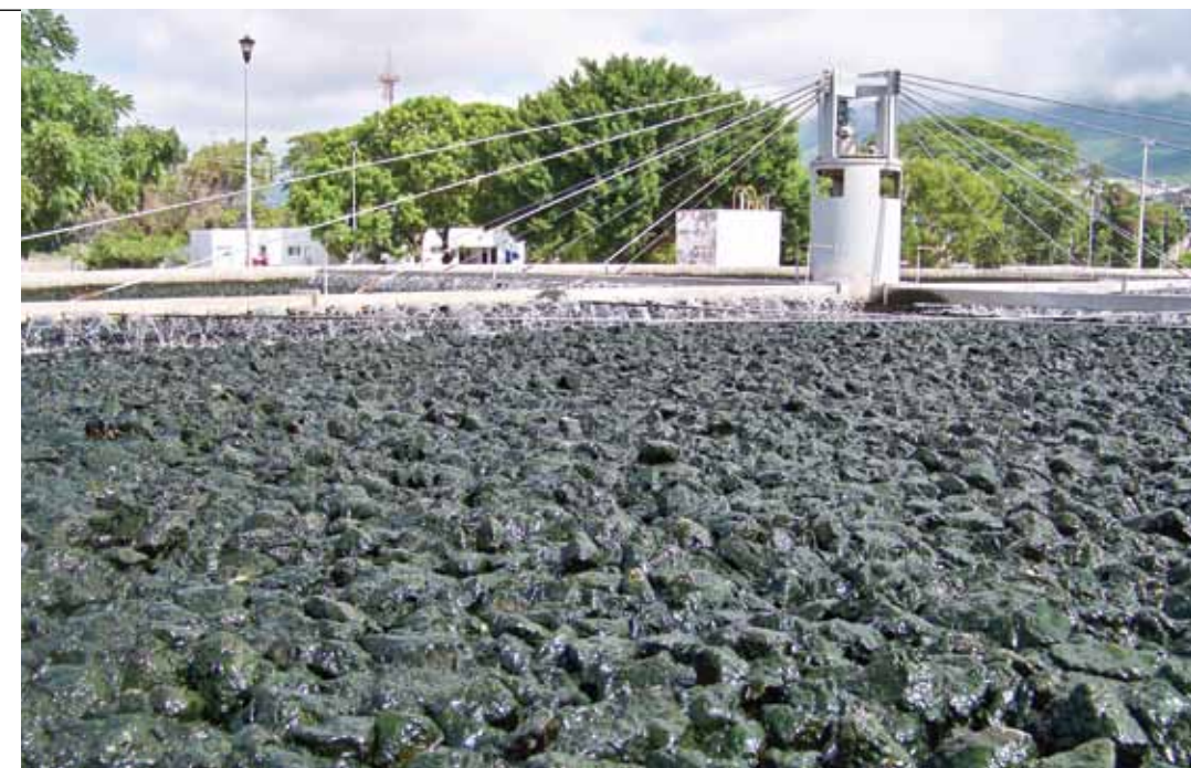
planta potabilizadora paso limón
