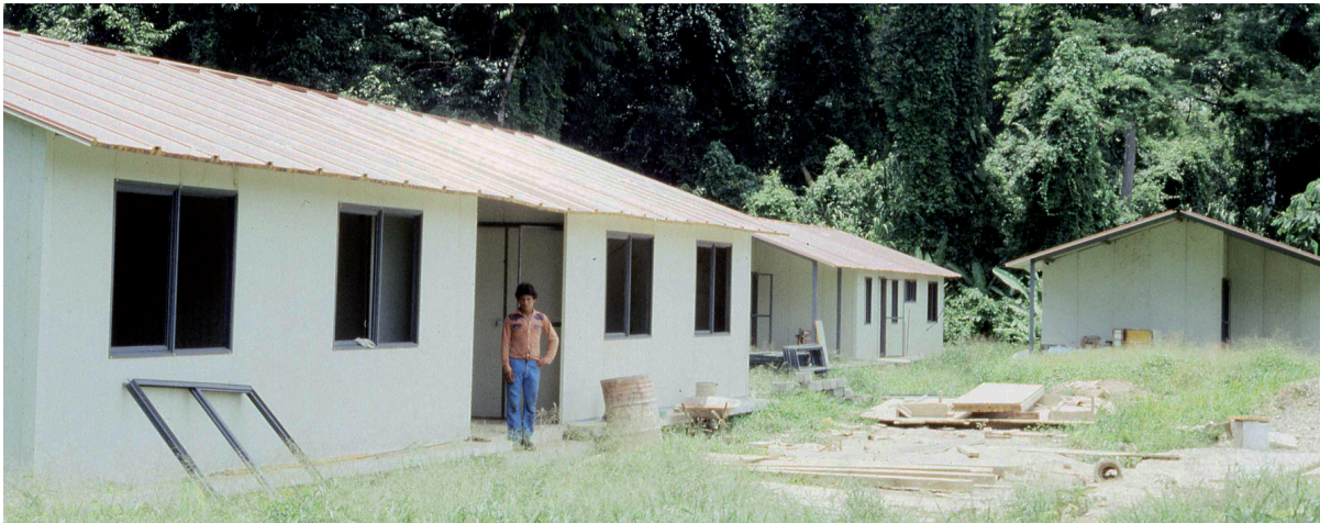
Construcción de la Estación Chajul, 1985. JME
