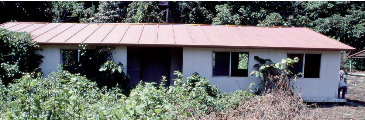
Rehabilitación de la Estación Chajul, 1989. JME
